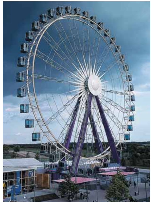
Constructeur : Gerstbauer Elektro GmbH - Méga-tour : Expo 2000 à Hanovre
