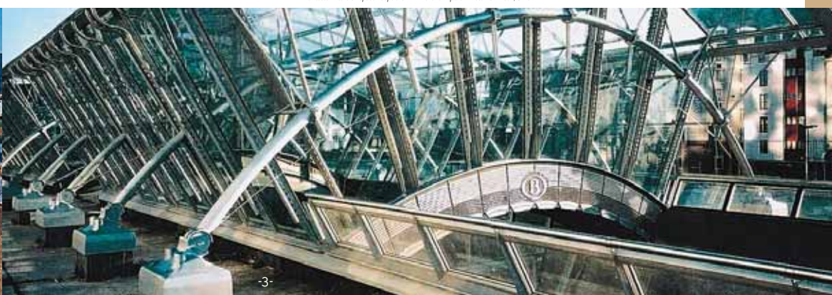
Architecte : Ateliers Espace Léopold S.A. - Michel Clinquart - Photo : S. Brisson, Ukkel
